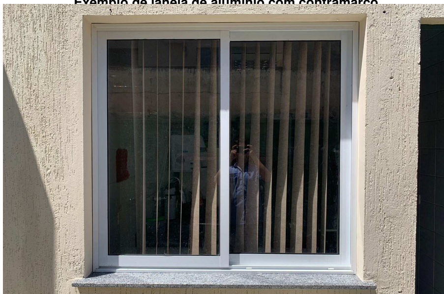
Exemplo de janela de alumínio com contramarco
